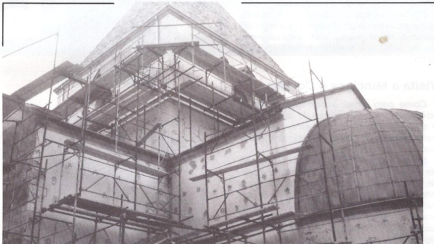
I lavori di settembre.
