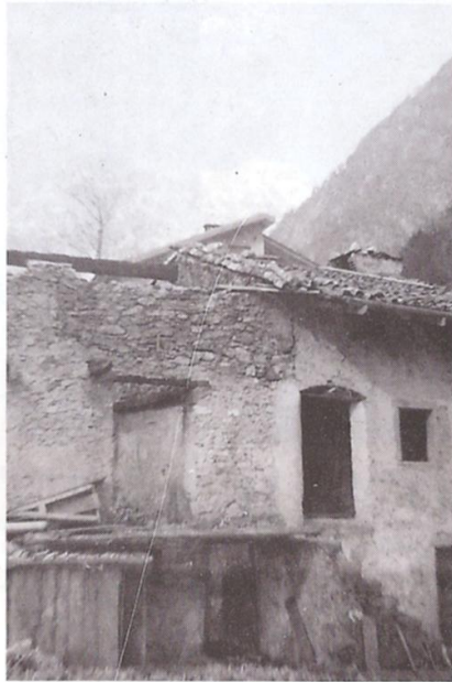
Prerit di Sopra: prima l'acqua, poi il fuoco distrussero il borgo.
