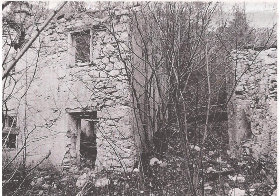
L'attuale stato del borgo Ponte di Muro.
