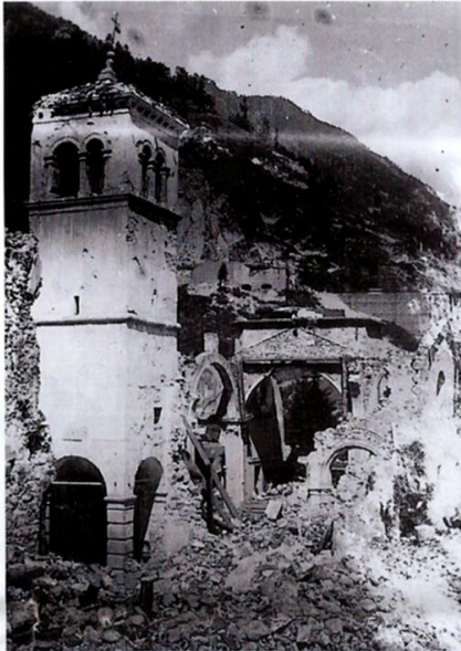
La Chiesa distrutta. Il campanile, gravemente lesionato, venne in seguito abbattuto.
