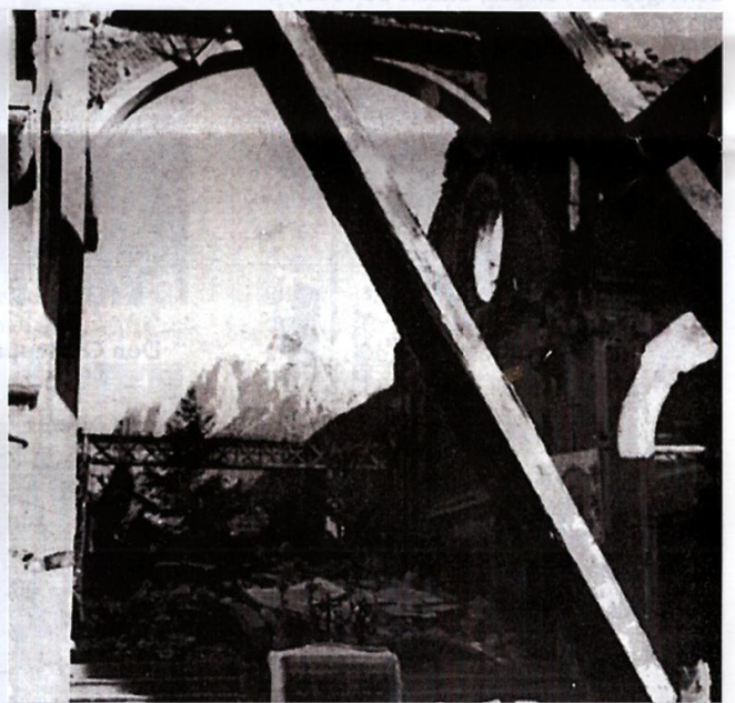
17 febbraio 1945. La Chiesa distrutta; sullo sfondo il ponte ferroviario, il vero obiettivo dei bombardamenti alleati, ancora intatto. Venne colpito, e solo in parte abbattuto, a guerra quasi finita.
