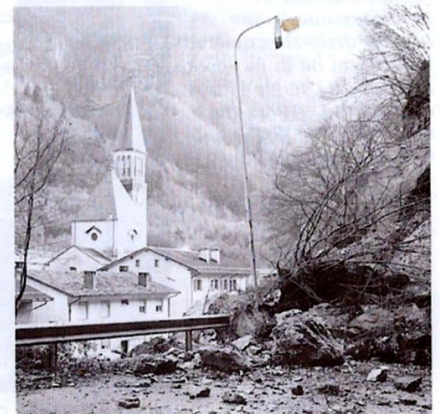
La frana di via Nazionale.
