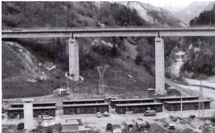
Prerit con i prefabbricati
