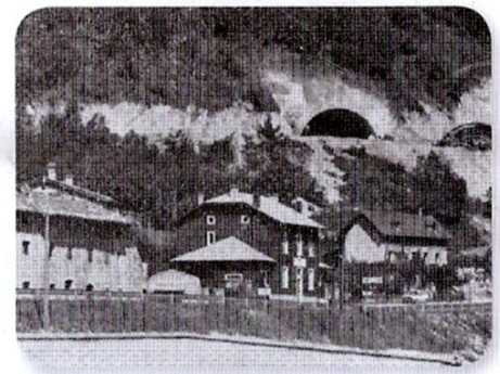
1980: Vidali con l'imbocco delle gallerie della futura autostrada
